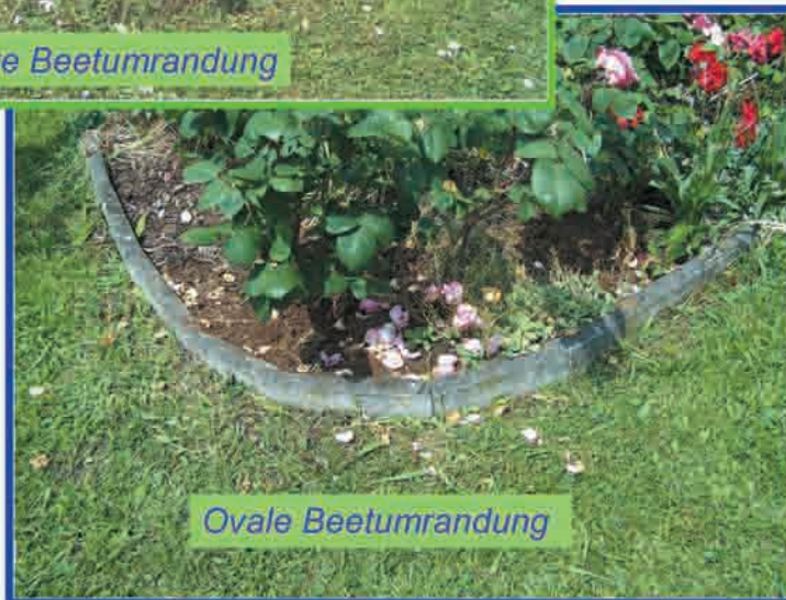
Abb. 2.11 – Die Form der Beetumrandung kann nach Belieben gewählt werden, aber bei der Verwendung von Betonleistensteinen muss viel (und genau) gesägt werden.
