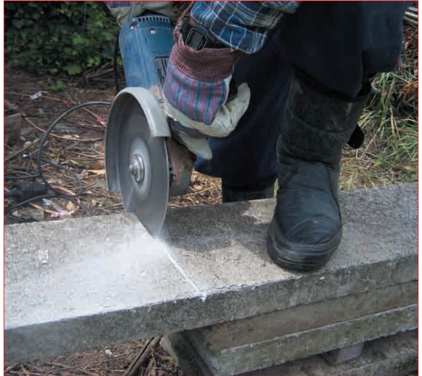
Abb. 2.15 – Dünnere Betonumrandungssteine können bei Bedarf mit einer Diamanttrennscheibe gekürzt werden: Verwenden Sie zu diesem Zweck grundsätzlich nur einen schweren Zweihand-Winkelschleifer, der für Trennscheiben mit einem Durchmesser von 230 mm ausgelegt ist.
