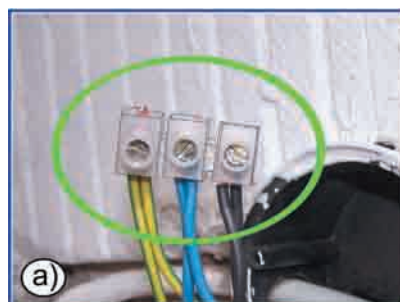
Abb. 7.27 – Bei den Verbindungen der elektrischen Leiter mit Dosenklemmen ist darauf zu achten, dass alle Leiter fest in der Klemme sitzen: Nachdem die Leiter festgeklemmt sind, ist eine Kontrolle durch kräftiges Ziehen an den einzelnen Leitern erforderlich.
