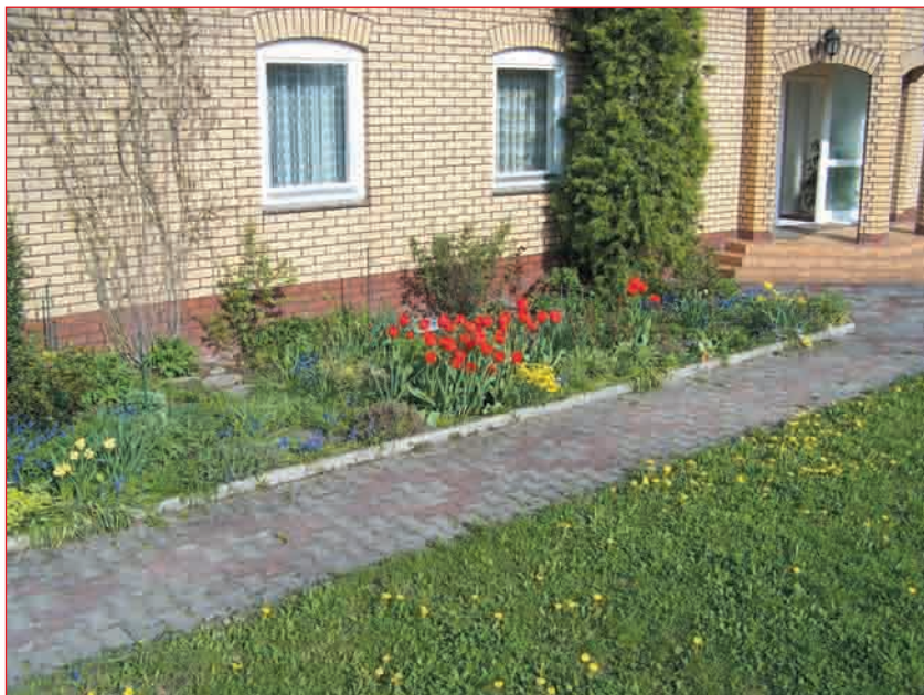
Abb. 3.1 – Gerader Gartenweg mit zweifarbigen Betonverbundsteinen
