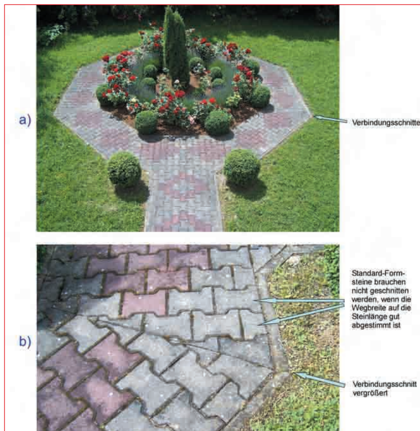
Abb. 3.33 – Beispiel eines achteckigen Rondells mit Verbundpflaster: In den Verbindungen müssen die Pflastersteine arbeitsintensiv geschnitten werden: a) Gesamtansicht; b) Detail einer Verbindung des Pflasters.
