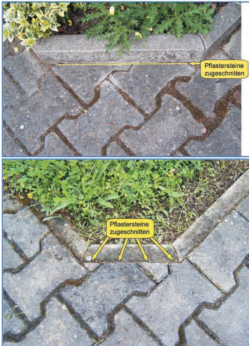
Abb. 3.18 – Betonpflastersteine lassen sich mit einem großen Zweihand-Winkelschleifer und einer Diamanttrennscheibe problemlos sägen. Wer sich die Mühe machen will, kann sie passgenau zuschneiden.
