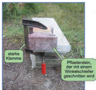
Abb. 3.32 – Der geschnittene Pflasterstein muss mit einer starken Stahlklemme auf einer massiven Platte festgeklammert sein.
