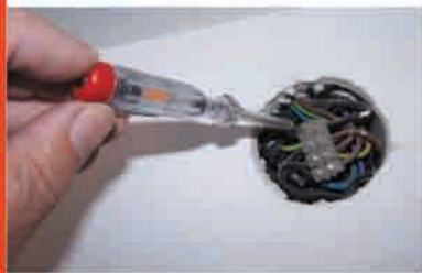
Abb. 7.26 – Für die Leiterverbindung in Abzweig- oder Verteilerdosen werden bevorzugt Dosenklemmen verwendet: Kräftiges Zudrehen der Klemmschrauben ist sehr wichtig.
