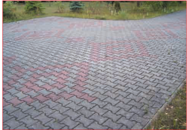
Abb. 3.14 – Verbundpflaster lässt sich leicht verlegen: Beispiel eines selbst verlegten Pflasters an der Garageneinfahrt.
