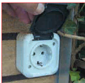
Abb. 7.17 – Feuchtraum-Steckdosen können im Garten nur dann fest installiert werden, wenn sie der Standort vor Regen oder Spritzwasser schützt – wie z. B. in einem Geräteschuppen.
