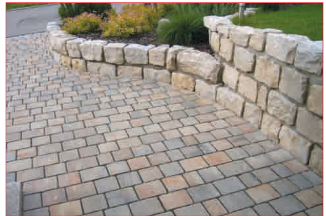
Abb. 4.2 – Form und Ausführung von Natursteinmauern im Garten bleiben der individuellen Fantasie überlassen. (Foto: RUF Baustoffwerk)
