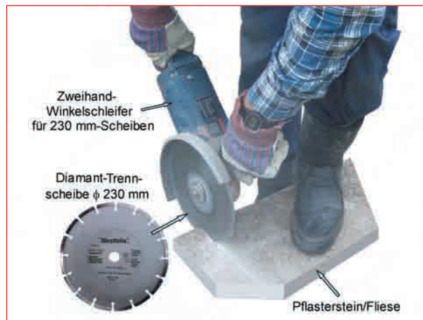
Abb. 3.31 – Das direkte Schneiden von Pflastersteinen oder Betonfliesen frei Hand setzt handwerkliche Erfahrung voraus.
