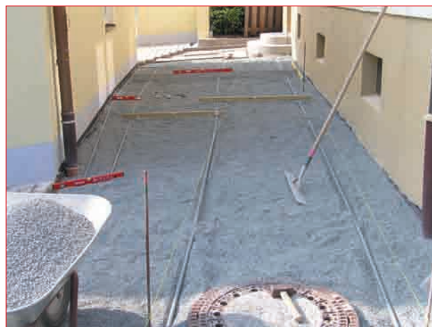
Abb. 3.7 – Für größere gepflasterte Flächen kann die Betung für das Pflaster in mehrere Bahnen eingeteilt werden, in die Rohre als Führungsschienen waagrecht verlegt werden, damit das Splittbett optimal gerade wird. (Foto: RUF Baustoffwerk)
