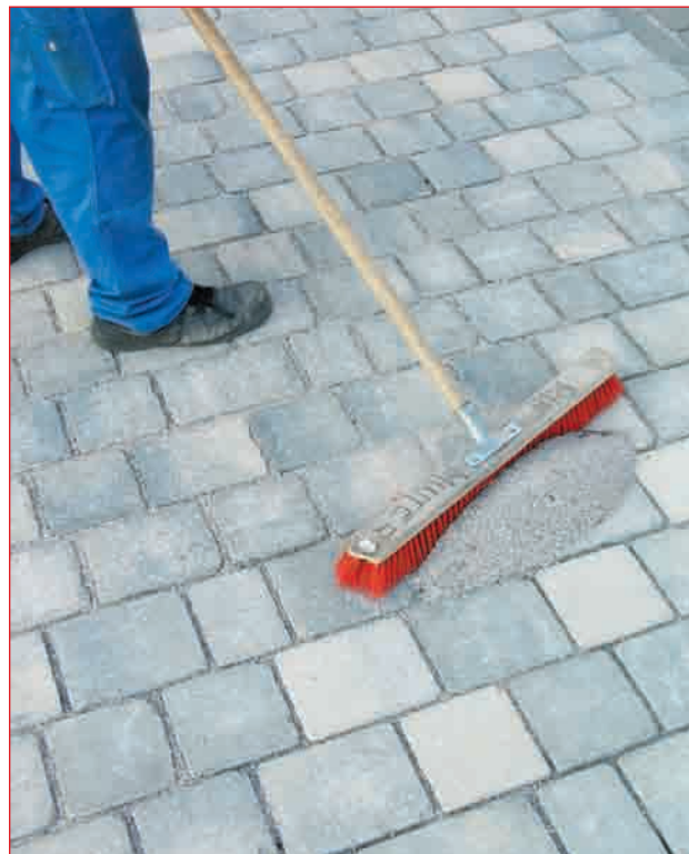
Abb. 3.22 – Der Sand oder Splitt wird mit einem Besen in die Fugen zwischen den Pflastersteinen hineingefegt.
