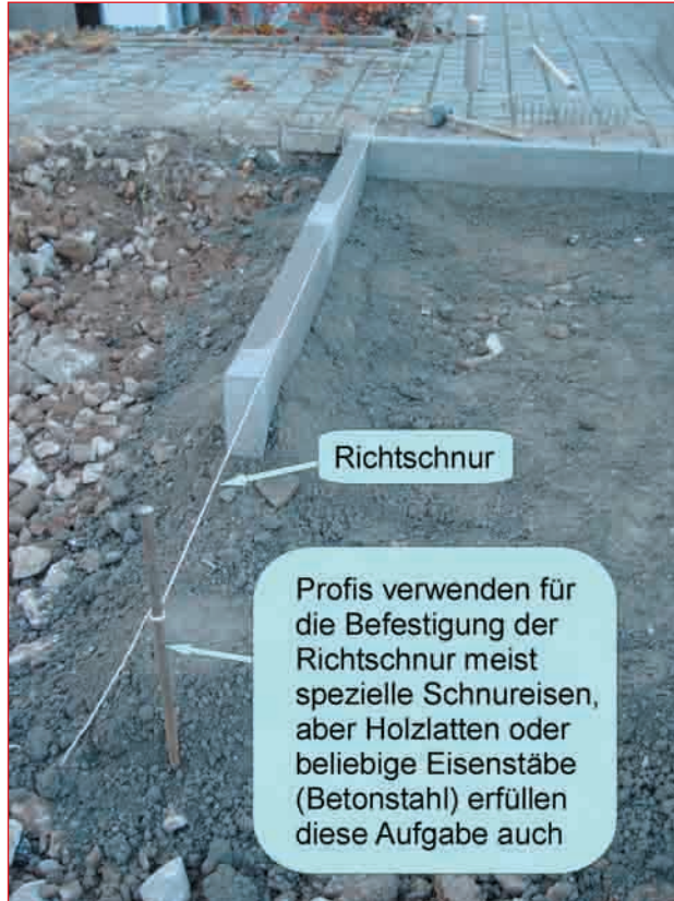
Abb. 3.27 – Beim Ausmessen und Aussetzen der Umrangungssteine ist höchste Präzision gefordert. (Foto: RUF Baustoffwerk)
